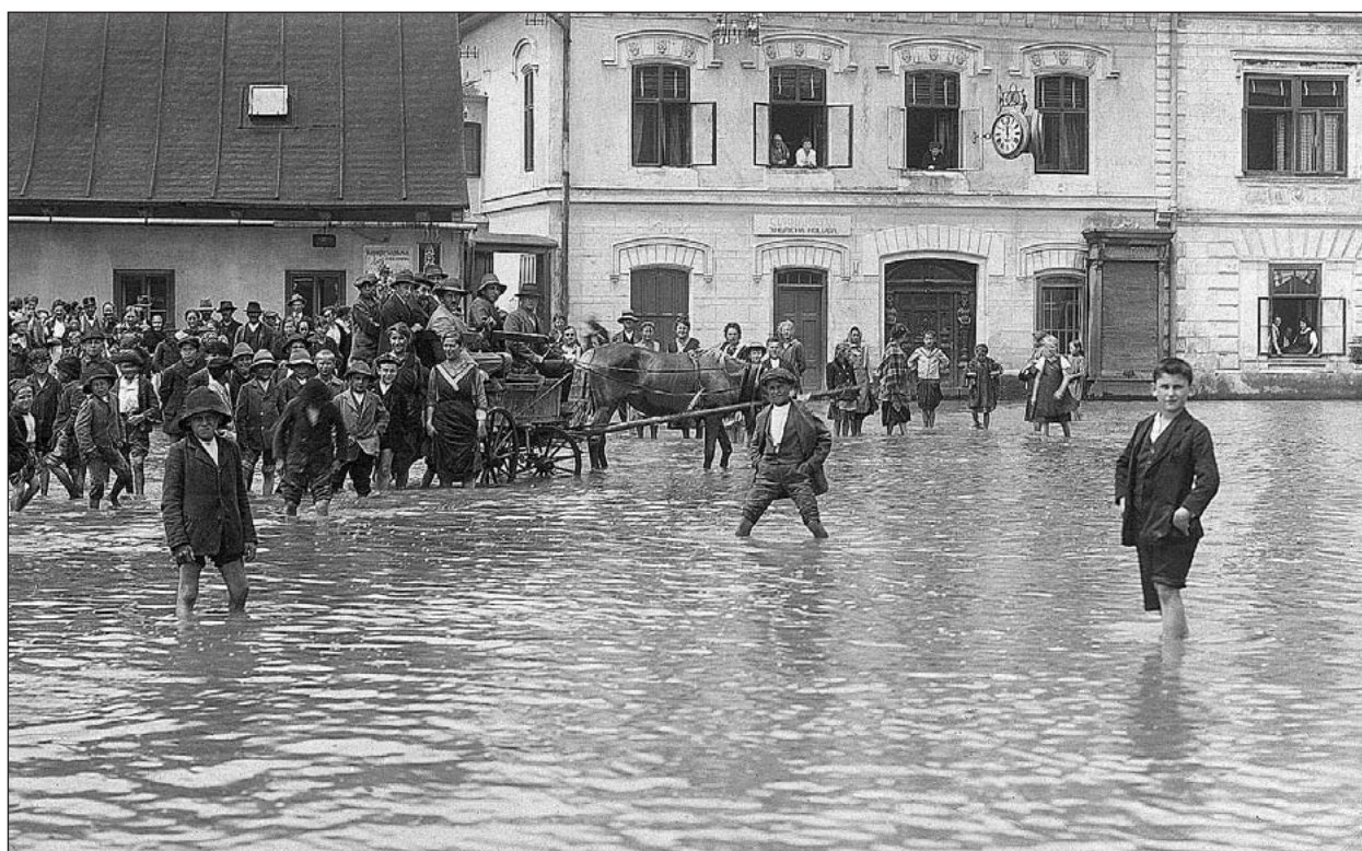
Povodeň ve Vsetíně - Dolní náměstí 1919
