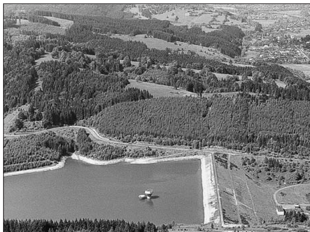
Vodní dílo Stanovnice - hráze, v pozadí Nový Hrozenkov
